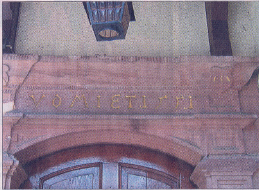
Alter Türsturz über dem Eingang zum evangelischen Pfarramt Gernsbach. Die Buchstabenfolge VDMIET ist die lateinische Abkürzung für das Motto der Lutheraner „Das Wort des Herrn bleibt in Ewigkeit“.
